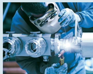
Montage von Rohrleitungen für Prozesanlagen.
