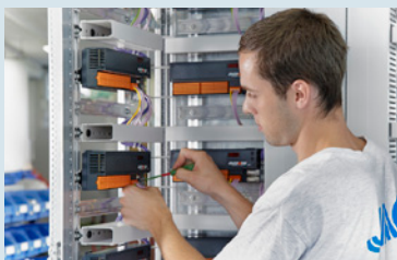
Montage von Steuerschränken für die Automation von Prozesanlagen.
