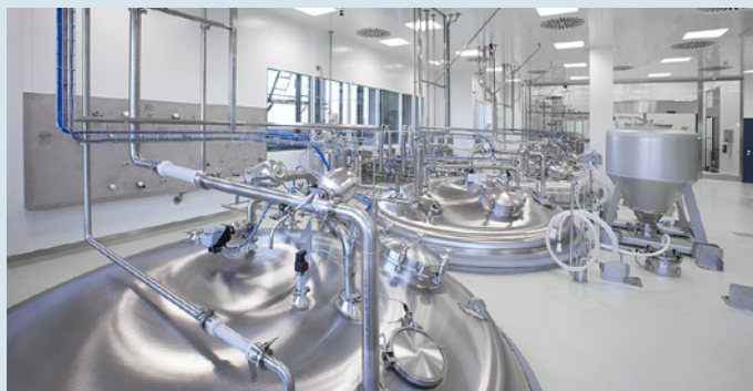
JAG plant und baut schlüsselfertige Prozesanlagen für die die Pharma-, Biotech- und Lebensmittelindustrie.
